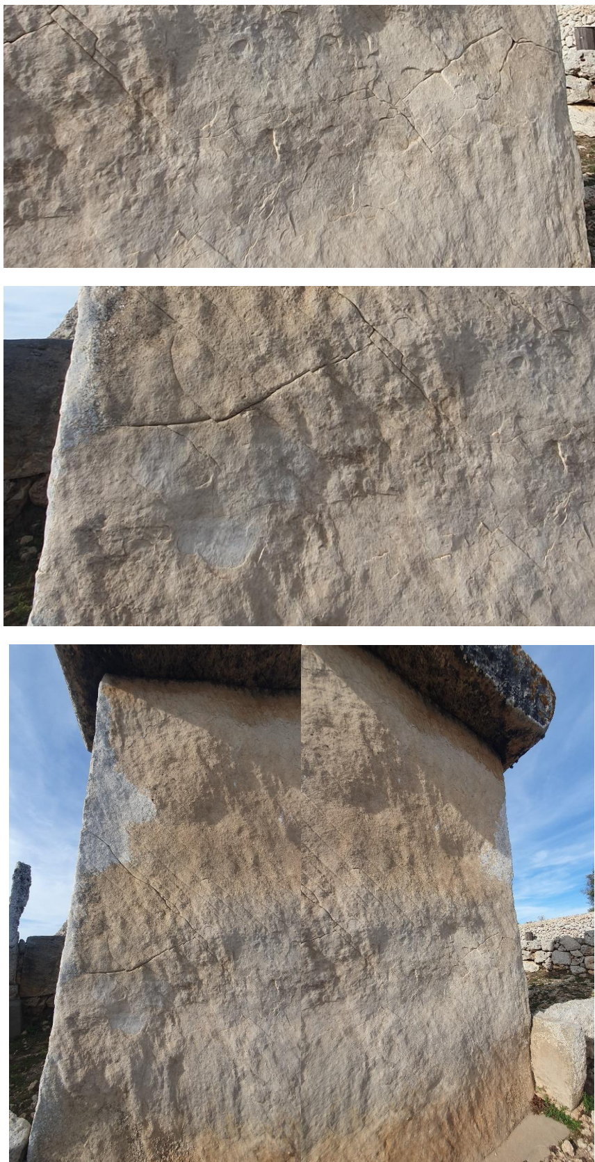
Figura 46. Detalls de diàclasis, fissures i laminacions del bloc de la taula.
