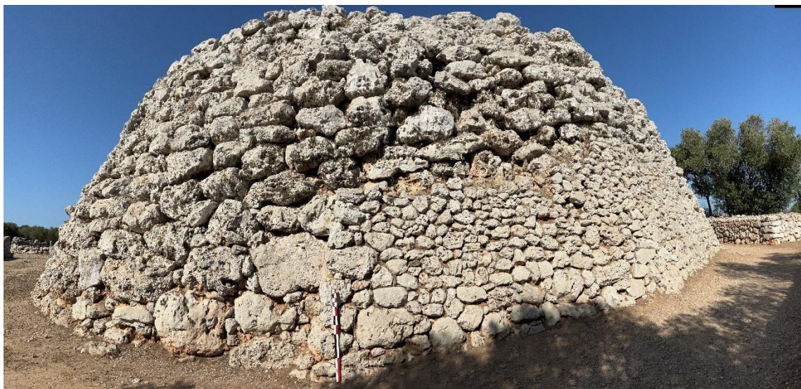
Figura 21. Vista del revestiment de paret seca que es va col·locar a la cara nord-est del T1 durant les obres de construcció de la fortificació del segle XVIII.
